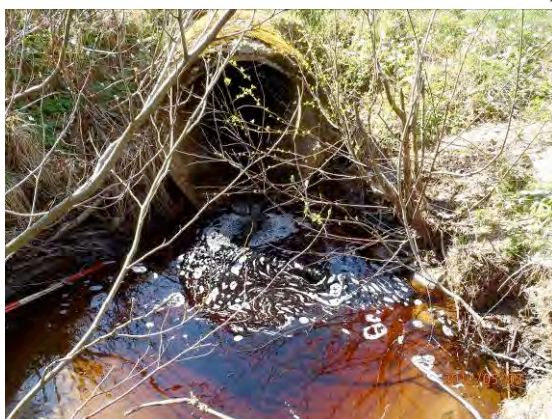
Bilden visar vägtrumma – vandringshinder
