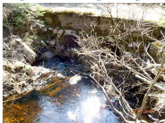
Vägtrummorna som utgör partiellt hinder.
