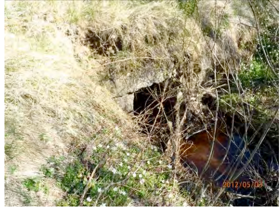
Bilden visar sten kulvert - vandringshinder
