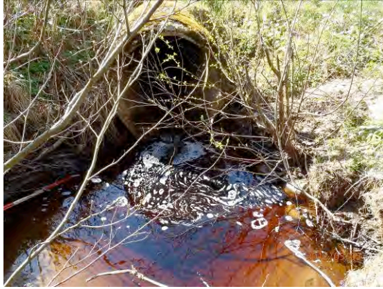
Bilden visar vägtrumma – vandringshinder
