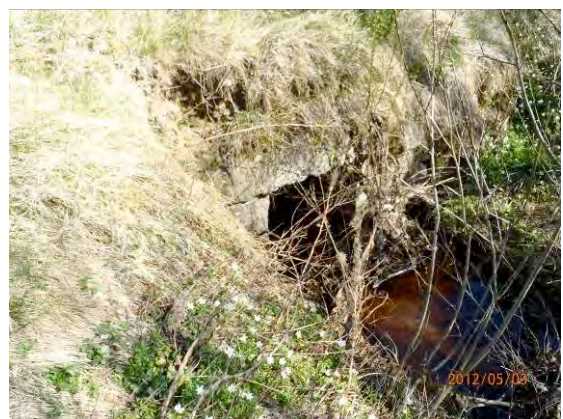
Bilden visar sten kulvert - vandringshinder
