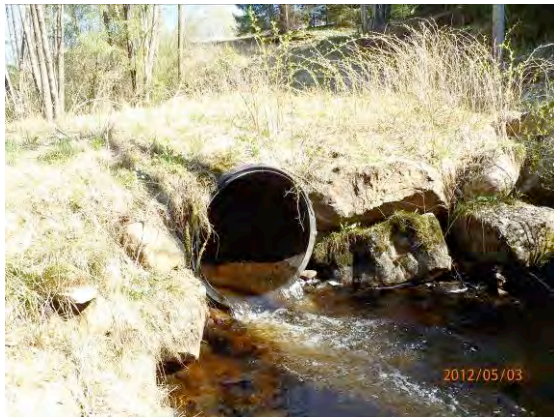
Den nylagda trumman utgör partiellt hinder för fisk. Signalkräfta fanns i hela vattendraget.
