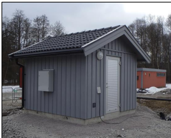
Figur 1. Exempel på pumpstation i Hillared.
