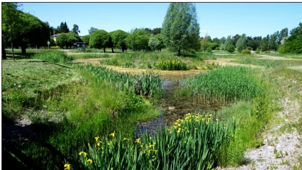
Figur 24. Exempel på en våt dagvattendamm, Visingedammen Täby kommun (VA-guiden, 2023).
