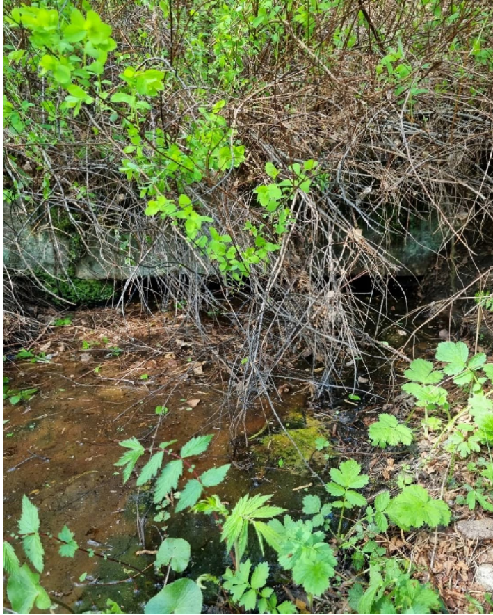
Figur 5. Foto på inlopp till stentrumma 2.
