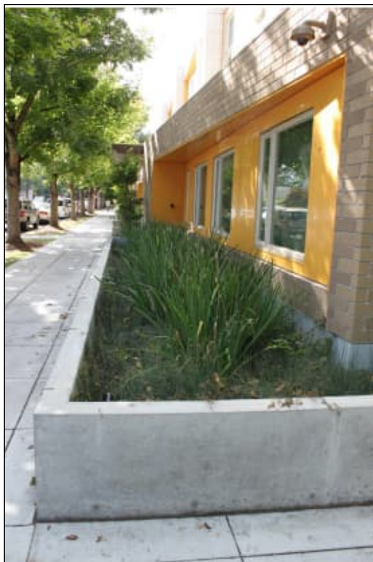
Figur 27. Växtbäddar som tar hand om takdagvatten (Stockholm Vatten och Avfall, 2023).
