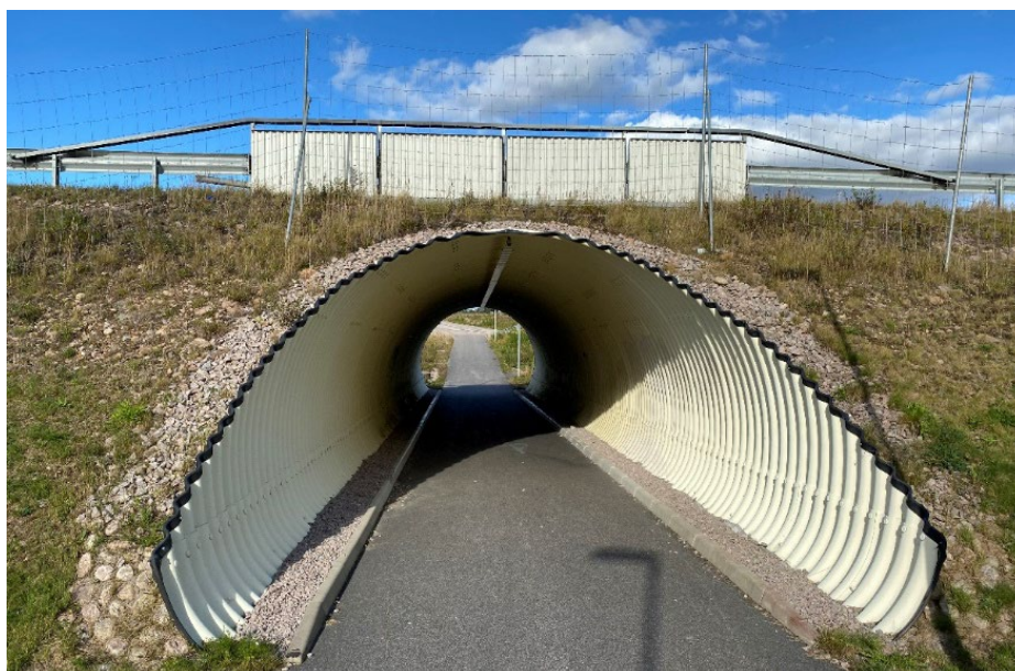
Figur 5. Bild av planskild passage under väg 27 vid Lockryd busstation.
