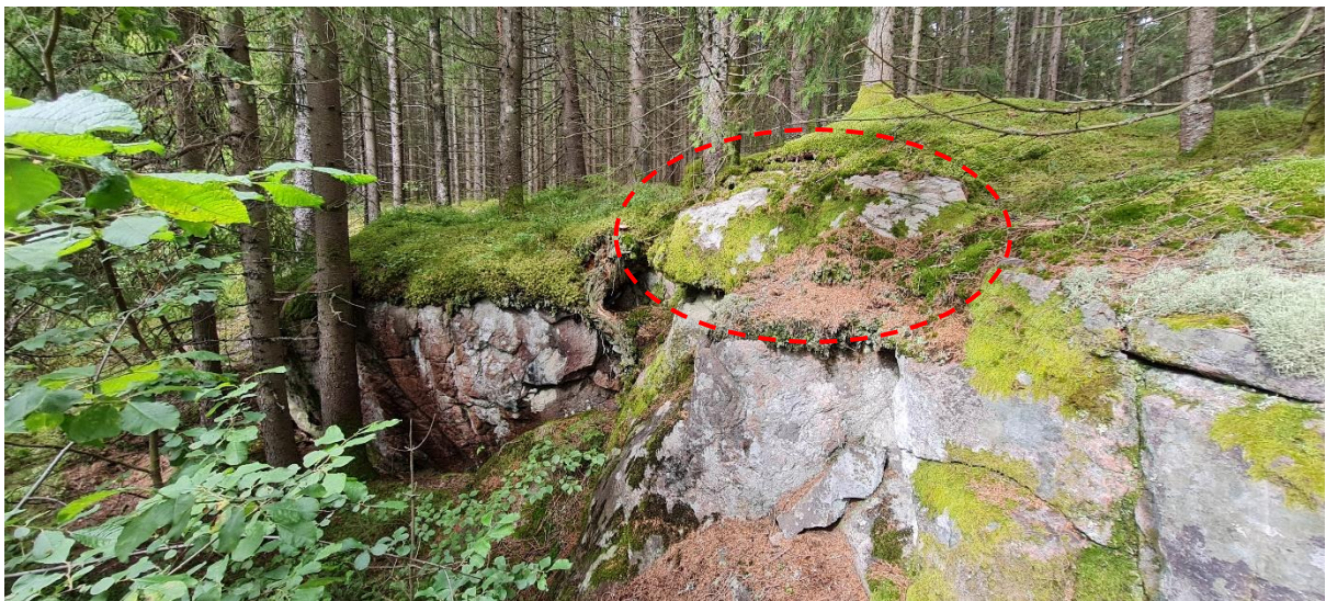
Figur 3. Foto av mindre slänt i område 2. Röd markering visar ett block som ligger på krönet.
