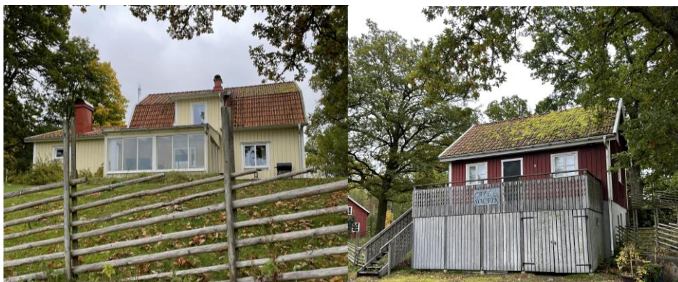
Befintligt bostadshus och befintligt café på Kalv 1:9, 2024.
