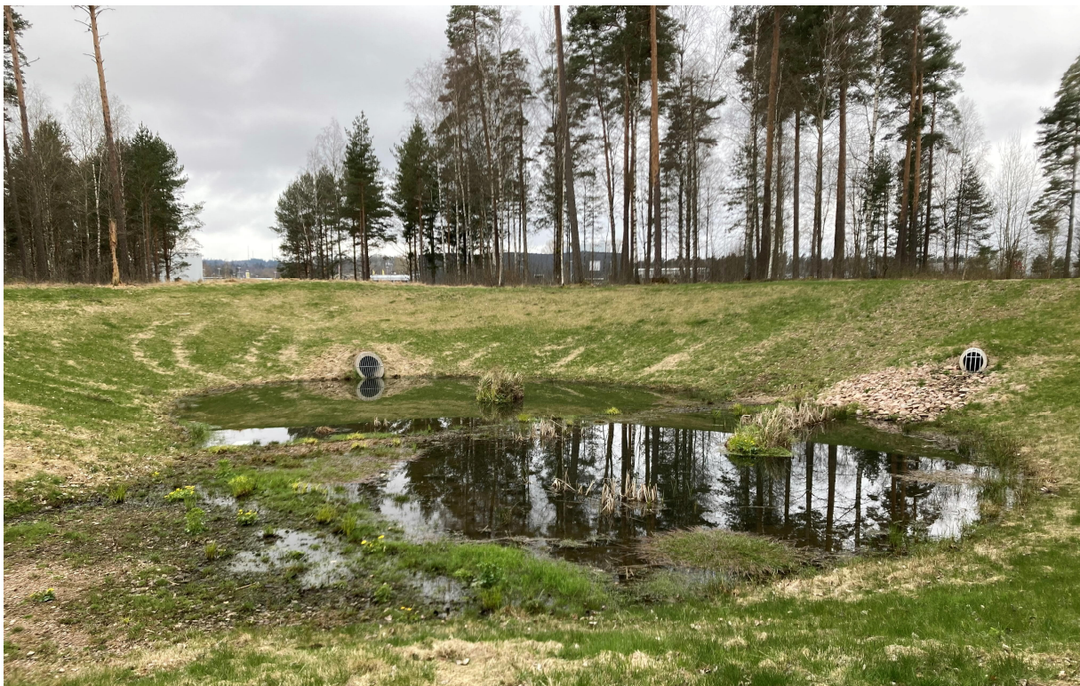
Foto 2. Den befintliga dammen. Inloppet till vänster i bild är Blåkläders ledning och den högra är från området norr om Blåkläder (foto Linus Johansson, Svenljunga kommun).
