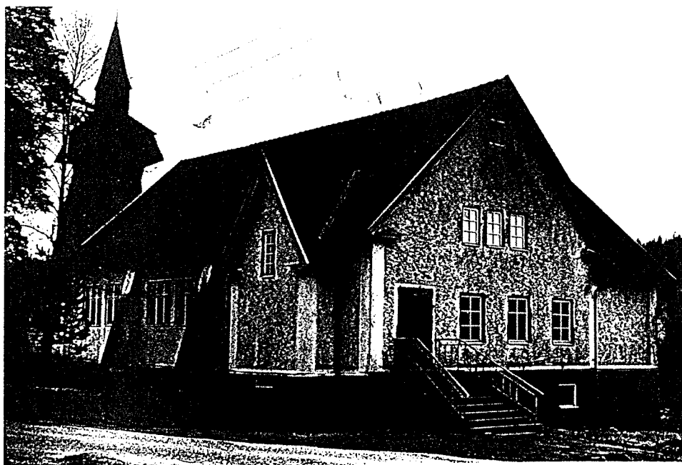
Kapellet vid Strömsfors som är det största i sitt slag i Sjuhäradsbygden användes till en början såväl för kyrkliga som världslika ändamål.
