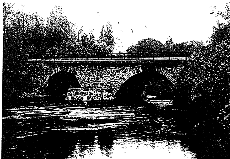
Stenvalvbron i två spann över Ätran i Östra Frölunda socken är utvärderad i grupp 1A i samband med broinventeringen i kommunen 1979–1980. Bron som är byggd i råhuggen sten i kall mur under 1847–1849 har strömkoner vid pelarens upp- och nedströms sidor och murverket stöttas med ankarslutar av järn.
