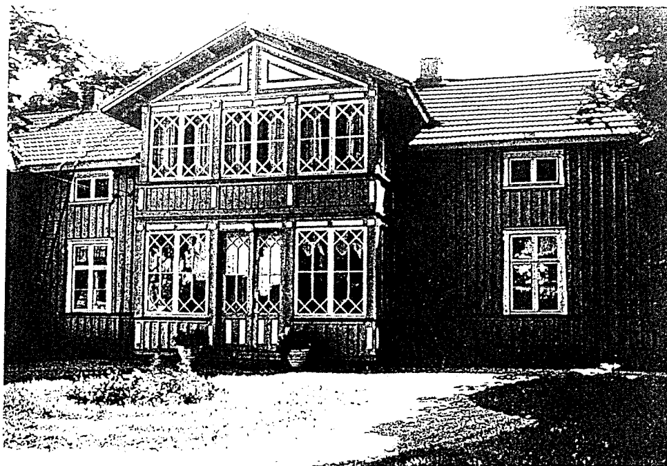
Mangårdsbyggnaden vid Kolarp 1:8 om- och tillbyggdes på 1870-talet men är enligt uppgift av betydligt äldre datum. Den mångspröjsade glasverandan tillkom ca 1905.
