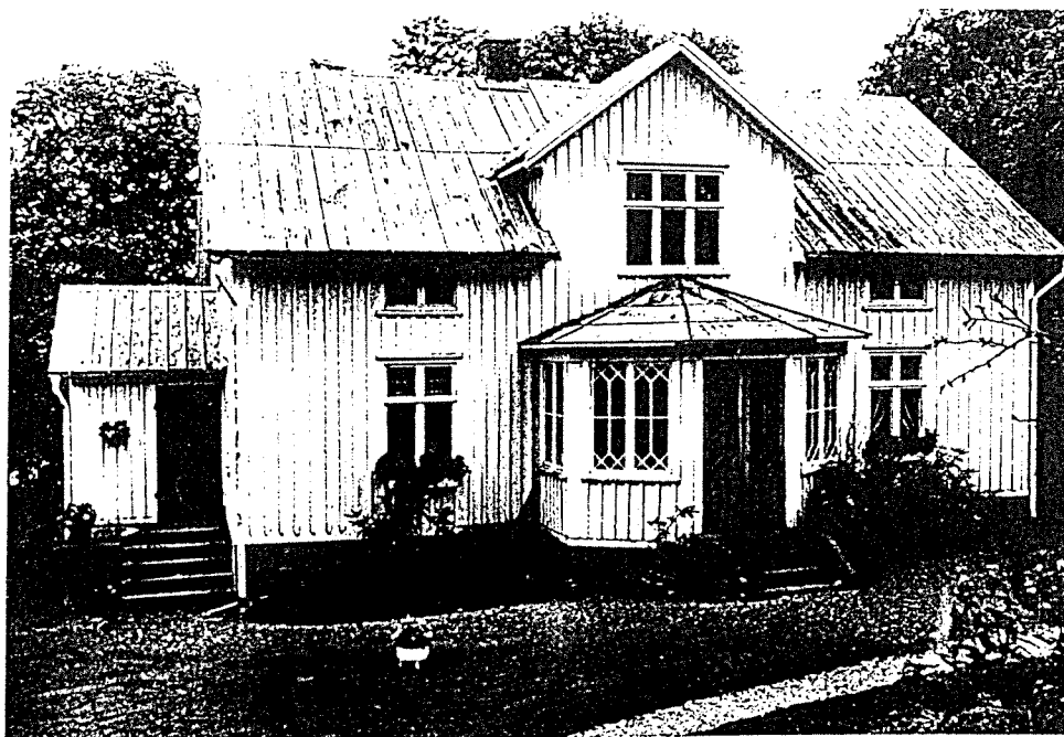
Boningshuset vid Mansås 1:2 ersatte år 1936 en äldre mangårdsbyggnad.
