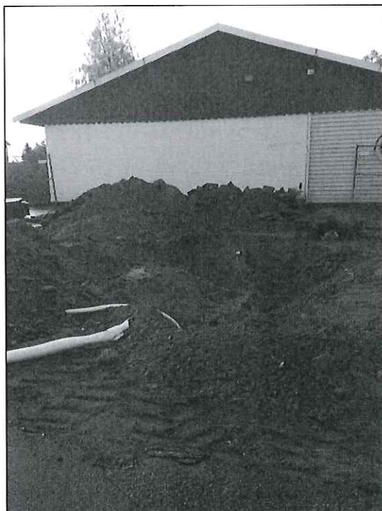
Figur 5. Schacht för pumpö. Foto: ÅF-Infrastructure AB
