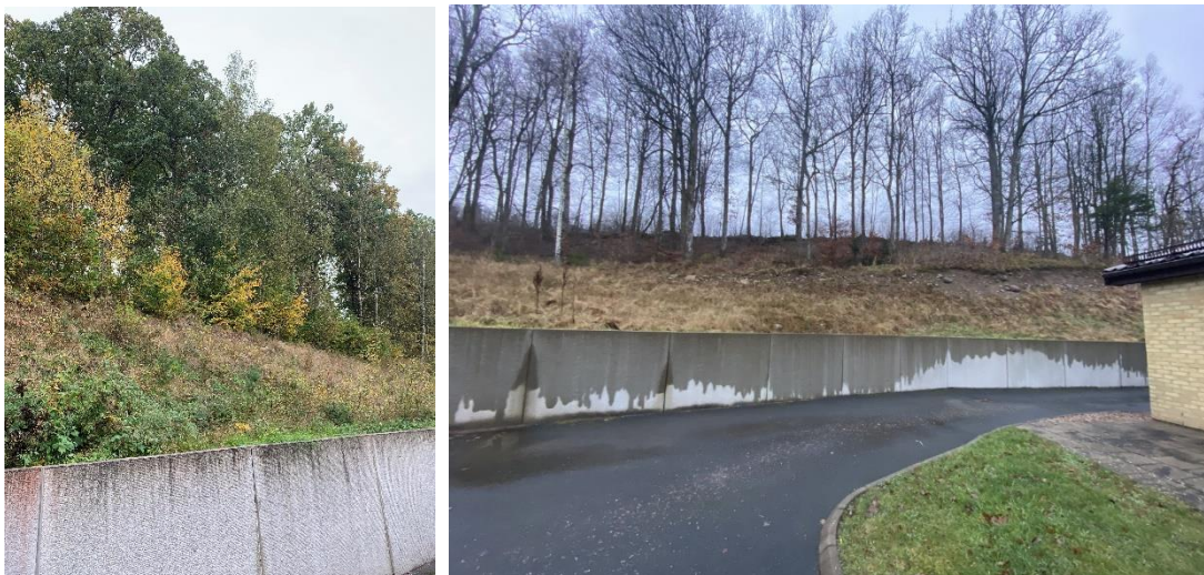
Befintlig vegetation i slänten och stödmur i planområdets västra del.
