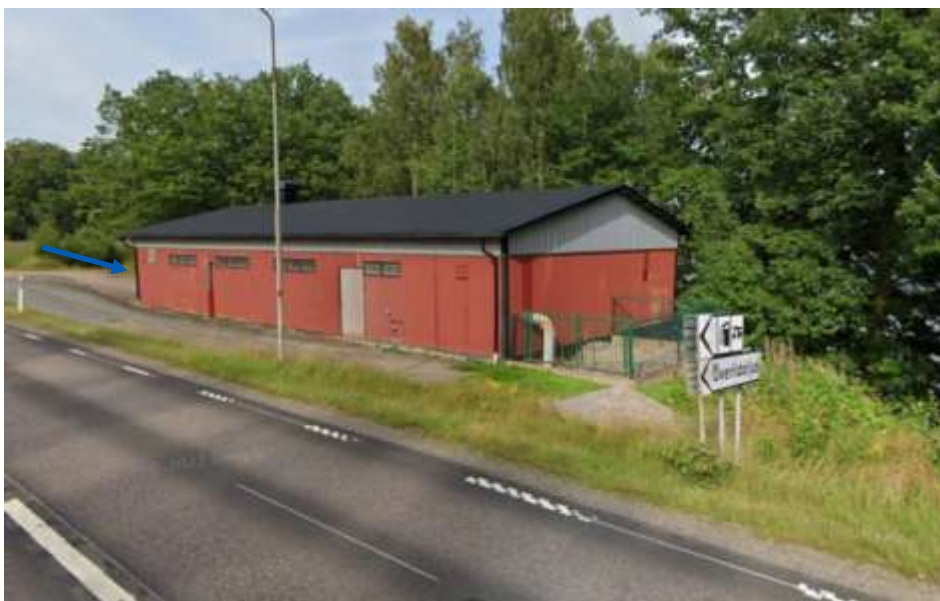
Figur 4. Vattnet avleds från vägen och mot byggnadens entré som ligger vid gul pil.
