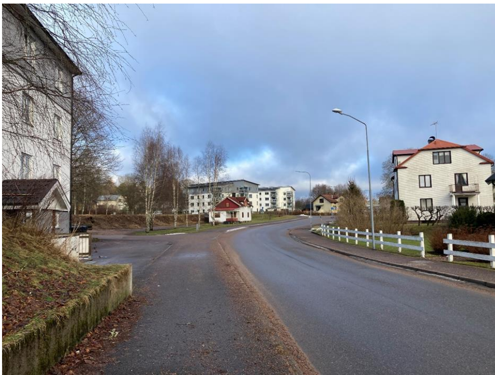
Bild 6. Foto från sydöst. Befintlig villa på planområdet står centralt i bilden med vit fasad och röd gavel. I bakgrunden syns moderna punkthus med vita och grå fasader. Till höger och vänster närmast i bild syns flerbostadshus av olika ålder och karaktär.
