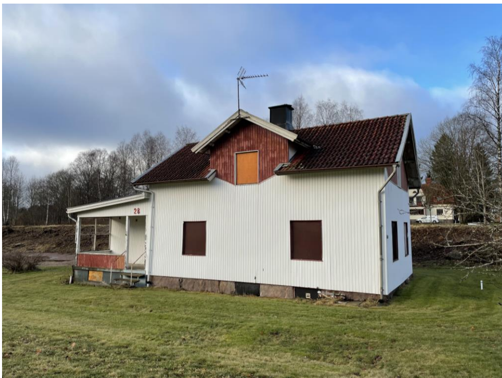
Bild 5. Befintlig huvudbyggnad i den nordöstra delen av planområdet.
