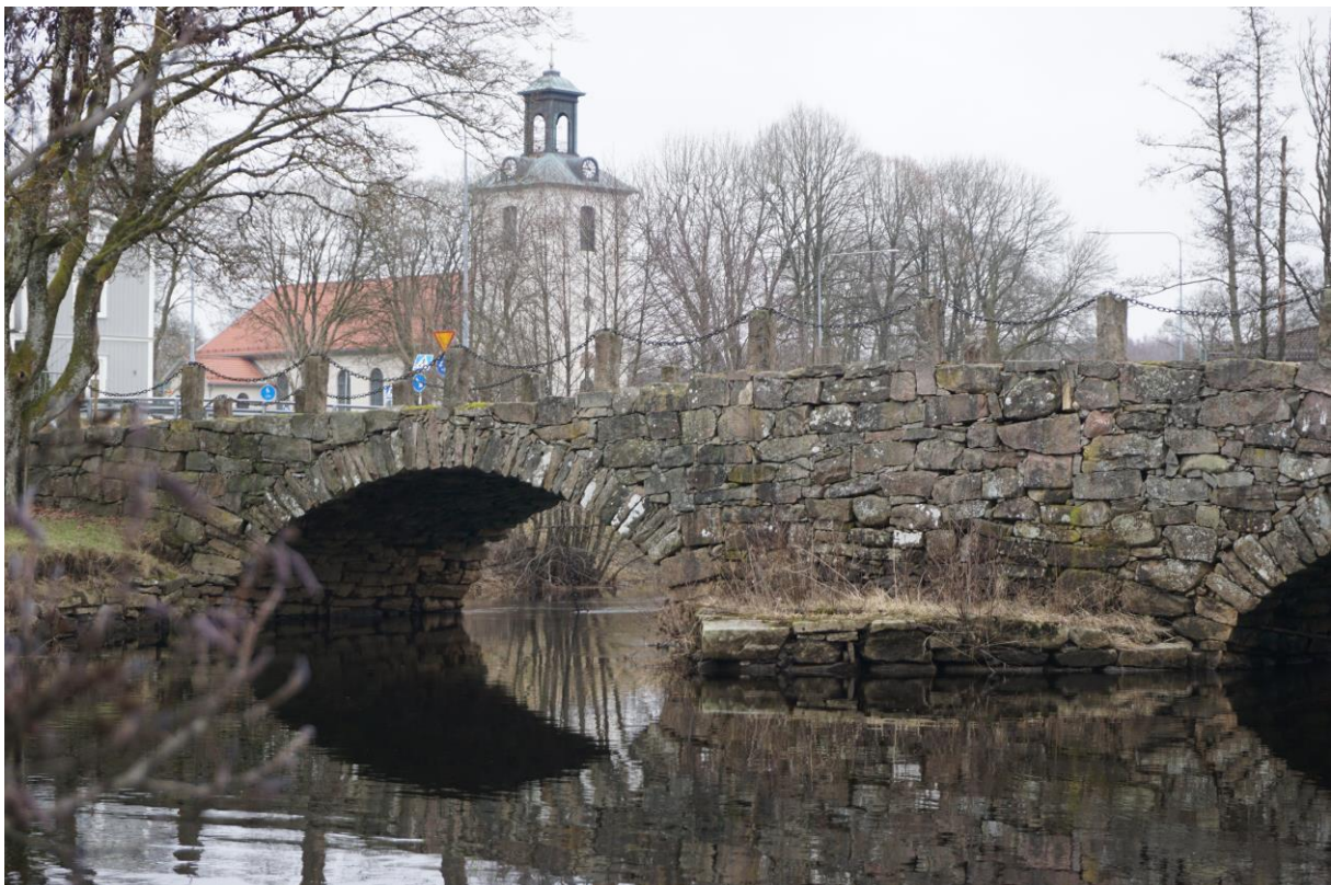
Stenvalsbron sett från nordväst med den "nya" kyrkan i fonden, byggd 1829. Strömnäbben sticker ut framför- och skyddar mittfundamentet. Räckesständer av sten sammanlänkade av kätting.
