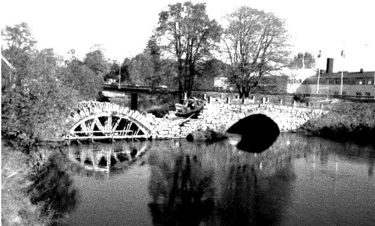
Fotografi från slutet av 1990-talet då bron plockades ned för att återuppbyggas i enlighet med traditionell teknik. Källa: Länsstyrelsen i Västra Götalands Län.
