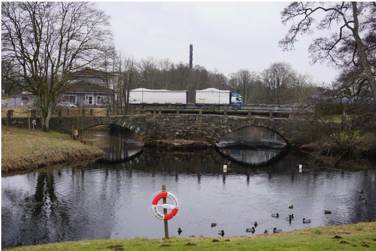
Stenvalvsbron sett från norr. Ett 20-tal meter söder om denna kör en lastbil över den bro som ersatte stenvalvsbron under tidigt 1900-tal och som sedan byggdes om under 1950-tal.
