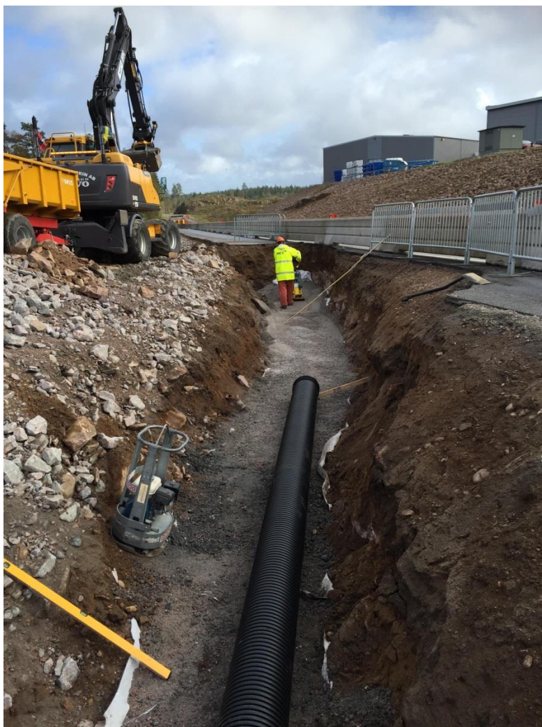
Bild 1: Ledningsarbete i Lockryd
