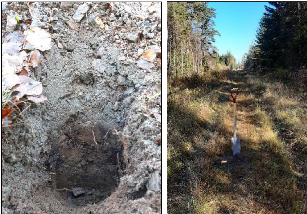
Figur 12. Foton från fältarbete 18 oktober 2022. Till vänster illustreras ljusare, nyligen tillagt, fyllnadsmaterial ytligt samt underliggande mörkare, äldre, fyllnadsmaterial. Till höger visas del av banvallen där cykelväg inte anlagts.
